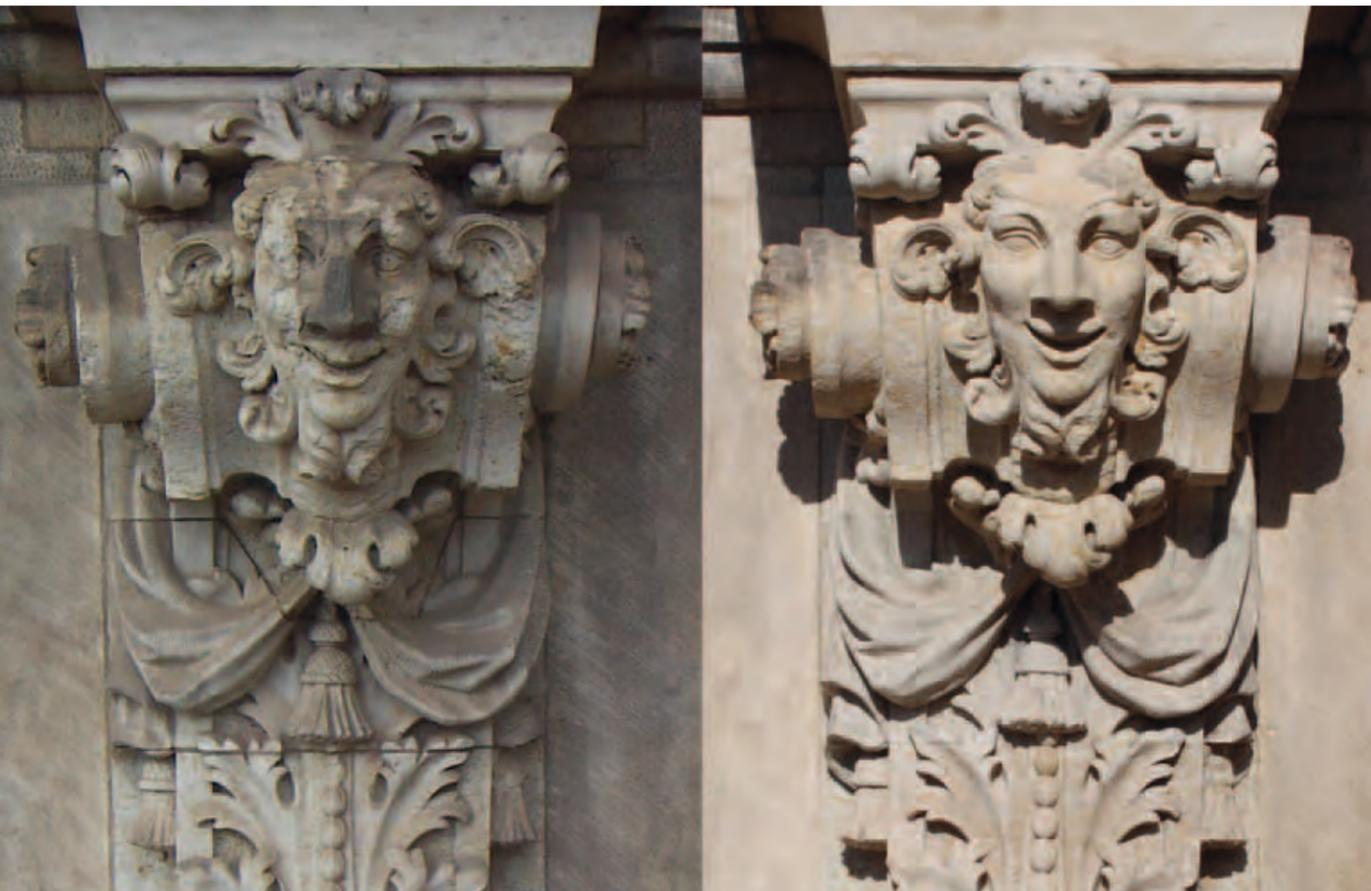
Linke Seite: Durch Salzeinwirkung stark geschädigte Maske einer Konsolfigur der Bogengalerien, links vor – und rechts nach der Restaurierung, 2009–2011
