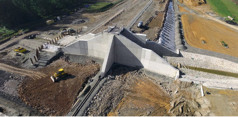
Dammbauwerk während der Bauphase
