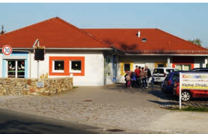
Neubau der Kindertagesstätte im Ortsteil Wildenhain (Passivhaus-Bauweise)
