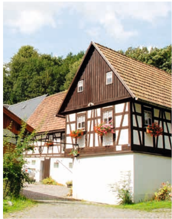
Niedermühle in Bräunsdorf
