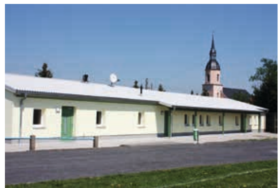
Saniertes Dorfgemeinschaftshaus im Ortsteil Bauda
