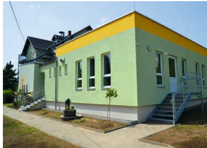
Sanierte Kindertagesstätte Lichtenhain
