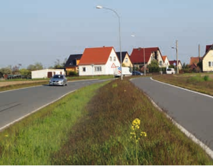
Ausbau der Ortslage Walda-Kleinthiemig (Kreisstraße 8570, 8582 und 8583) mit Neubau eines straßenbegleitenden Radweges (Gemeinschaftsmaßnahme Landkreis Meißen und Große Kreisstadt Großenhain)
