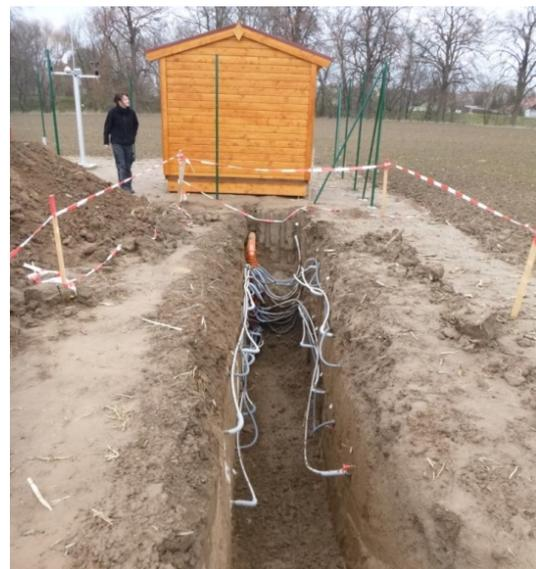
Abb. 20: Stationsgebäude und offener Schurf mit Sonden auf der neu errichteten BDF II-Fläche Köllitzsch
