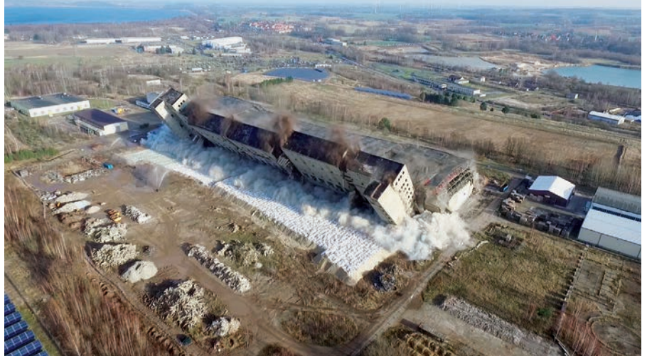
Drohnenaufnahme der Zündung – gut zu erkennen ist der punktgenaue Sturz in das vorbereitete Fallbett zur Schwingungsminimierung
