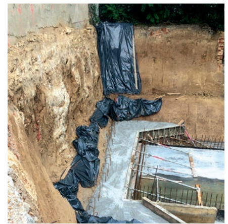
Absteifende Baugrubensicherung durch bewehrten Betonkeil
