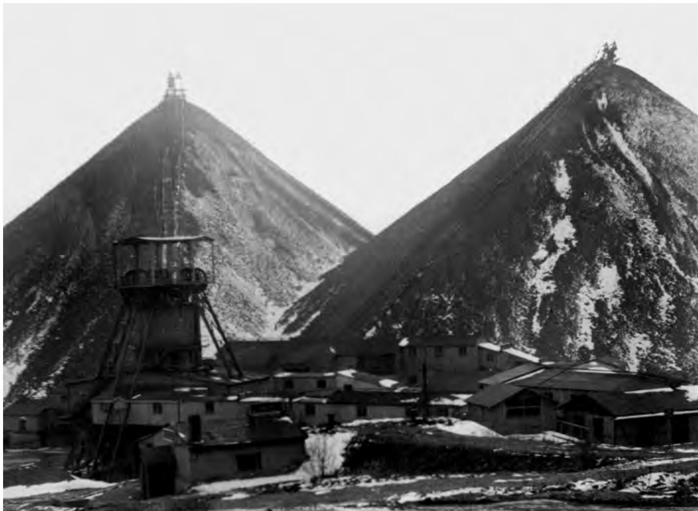
Abb. 3-48: Teilansicht der Anlagen von Schacht 277 um 1955 (©Archive Wismut)
