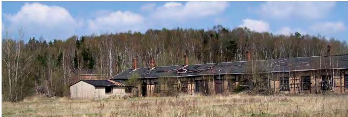
Abb. 3-55: Gebäudereste am ehemaligen Schacht 277
