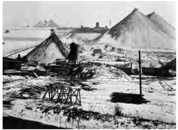
Abb. 1-6: Blick vom Forellenbachtal über Schacht 354 und 320 zum Schacht 362 (um 1955, ©Archive Wismut)
