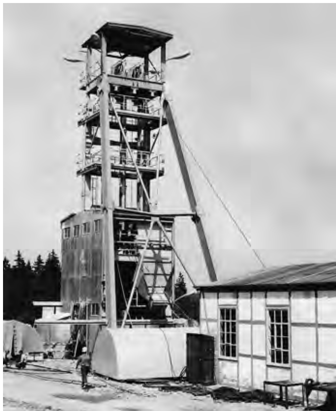
Abb. 5-16: Fördergerüst des Schachtes 404, Rebesgrün
