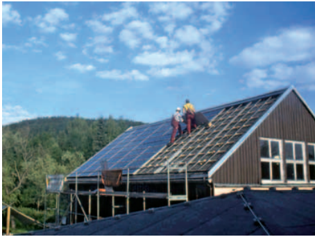
Abb. 14: Bau der Bürgersolaranlage auf dem Dach der Biotoppflegebasis 2005 Foto: J. Weber
