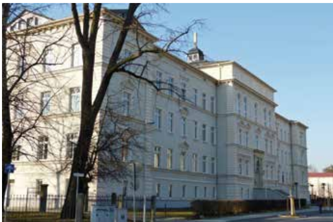
A-Gebäude Geschwister-Scholl-Gymnasium Löbau
