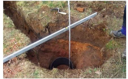
**Abb. 27:** Grube für Seismometerschacht: Unter dem Boden (graubraun, ca. 30 cm mächtig) ist der nur leicht angewitterte Kirchberger Granit in seiner felsigen Beschaffenheit in den helleren Brauntönen deutlich erkennbar. In der Mitte erreicht die Baugrube eine Tiefe von 1 m; das ca. 30 cm hohe Rohr dient als Schalung, in die der Betonsockel gegossen wird, Oberkante ca. 65 cm unter Gelände. Links oben im Bild der Kabelgraben für die Anschlussleitungen. Quelle: Klaus Weißenfels
