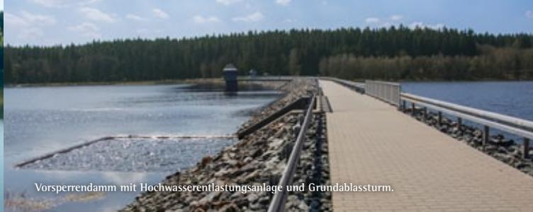
Vorsperrendamm mit Hochwasserentlastungsanlage und Grundablassturm.
