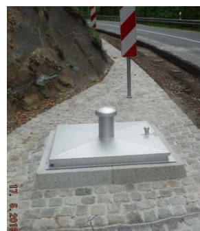
Abb. 3: sanierter Quellauslauf
