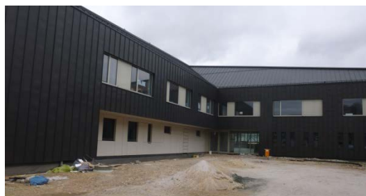
Abb. 9: Baustelle im März 2017
