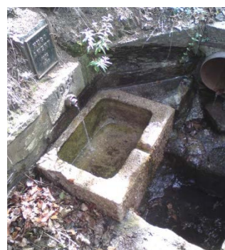
Abb. 2: Quelle Oberpfannenstiel mit Auslaufrohr und Messtroß aus Stein, unmittelbar an der Straße.
