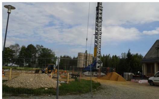
Abb. 8: Baustelle im September 2015
