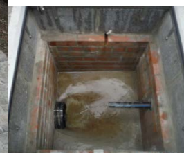
Abb. 4: Messschacht ohne Messtechnik
