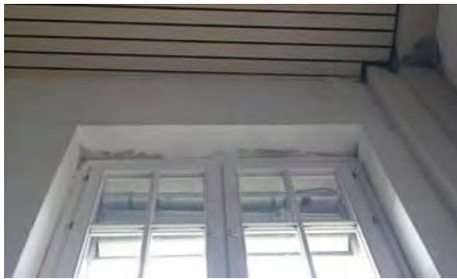
Abbildung 12: Schimmelschäden im Deckenbereich und den Fensterlaibungen einer Turnhalle
