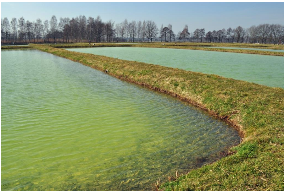
Abbildung 13: Teilansicht der VTA nach Branntkalkausbringung mit STREUMAX. Deutlich sind die gleichmäßige Verteilung des Branntkalks und ein ausgeprägtes Klarwasserstadium zu erkennen.
