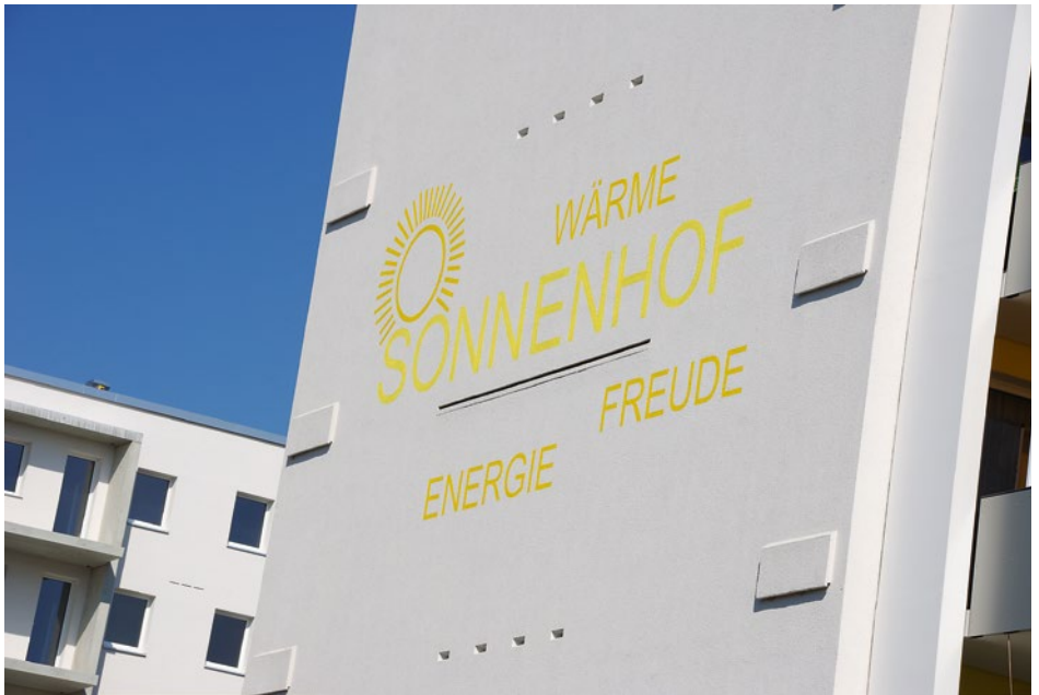
In die Fassade integrierte Quartiersteine für Fledermäuse Foto: Thomas Frank
