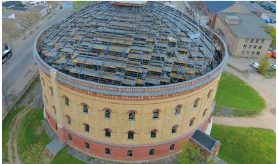
Gasometergebäude mit eingerüsteter Dachkuppel (Foto Bürger)
