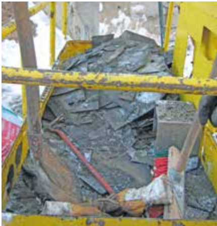
Verwendung von Besen und Schaufel bei der Beräumung
