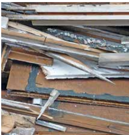
Reste der Holzrahmenkonstruktion mit Anhaftungen von Morinolfugenkitt
