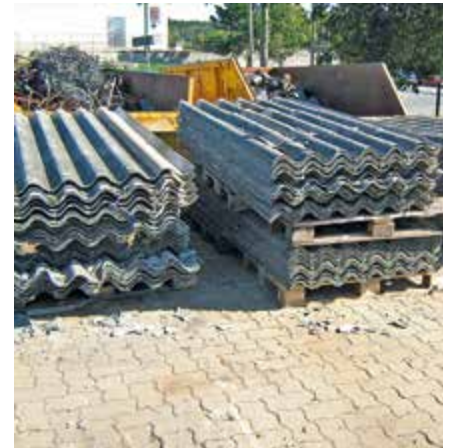
Keine Unterbindung der Asbestfaserfreisetzung bei demontierten Asbestzementplatten
