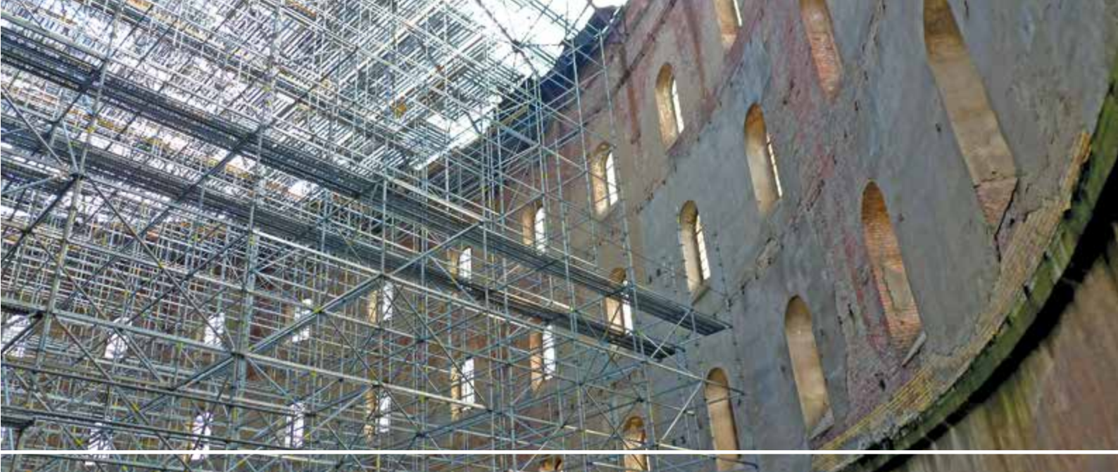
Gasometergebäude innen – Raumgerüst im Aufbau (Foto LDS)
