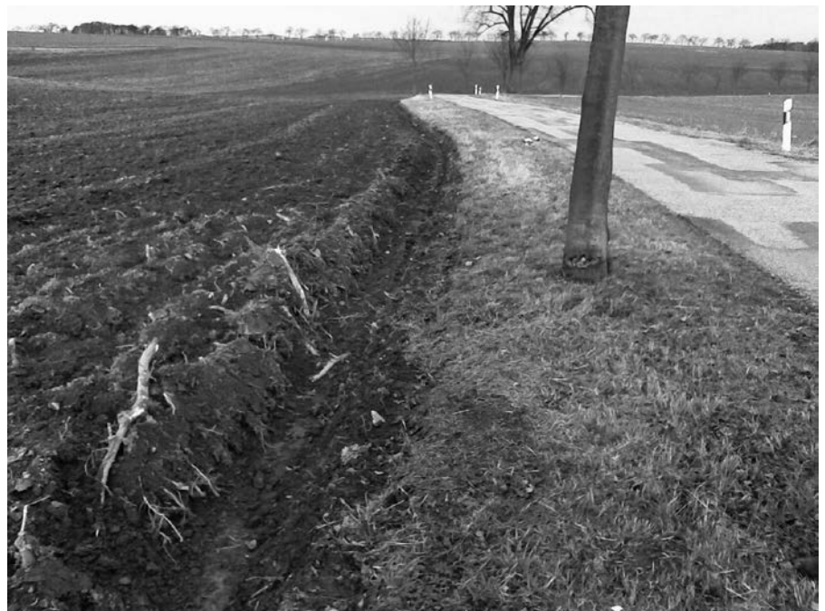
Zerstörung eines Straßengrabens durch den Pflug, Foto: Landkreis Görlitz
