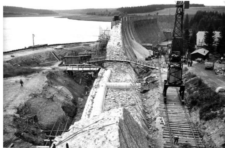
Bruchstelle an der Talsperre Muldenberg nach Explosionsunglück zu Kriegsende, Wiederaufbau 1949, Quelle: LTV
