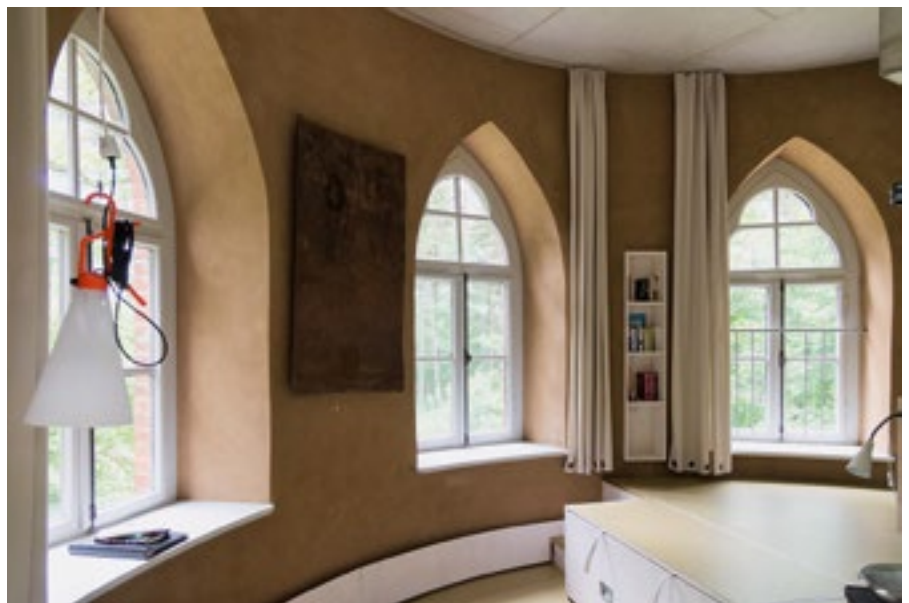
Die Wände wurden ökologisch mit Stroh und Lehm verputzt, die Heizung in der Fußleiste versteckt.
