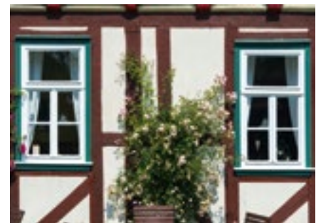
Fachwerk und Fenster – auf jedes Detail wurde bei der Sanierung Wert gelegt.
