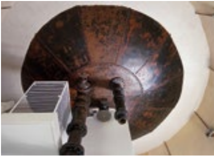
Auf Anregung der Denkmalpfleger wurde der Kesselboden bei der Neugestaltung mit integriert.
