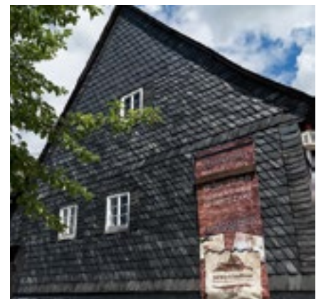
Die Originalsubstanz des 300 Jahre alten Hauses wurde bei der Sanierung erhalten.
