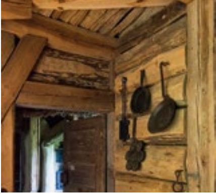
Für den Anbau verwendete Butzeck Holz von Abrisshäusern. Die Decke ist aus gebrauchten Lehmstaken.
