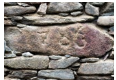
In der Außenmauer der Scheune haben die Sturges das Baujahr entdeckt.
