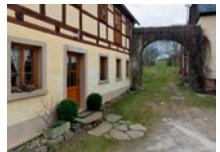
Der Erhalt des Torbogens war eine bautechnische Herausforderung.
