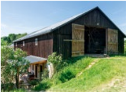
Die 200 Jahre alte, denkmalgeschützte Scheune wurde aufwändig saniert.
