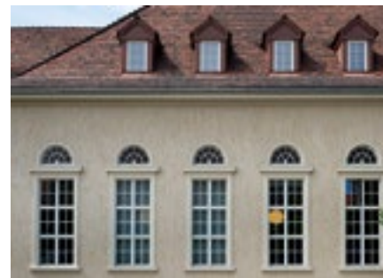
Auch die Fassade des klassizistischen Baus wurde saniert.
