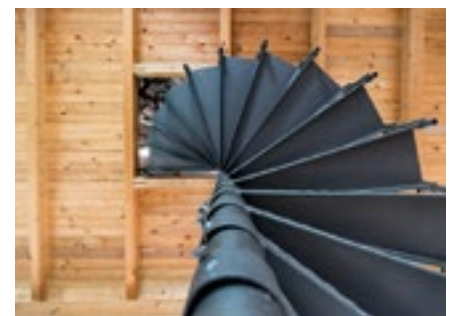
Die filigrane Wendeltreppe in den oberen Wohnbereich fügt sich unauffällig ins Kirchenschiff ein.
