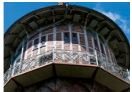
Der Wasserturm war bereits 1896 auch als Aussichtsturm konzipiert.
