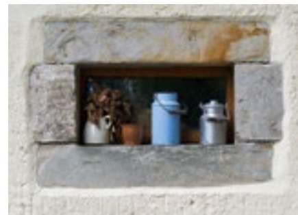
Prägen das Gesicht des Hauses: Fenster- und Türfaschen aus Sandsteinblöcken.
