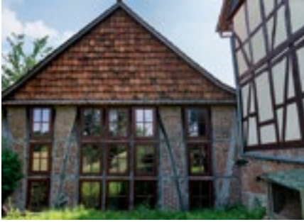
Bei der Sanierung der Scheune wurden viele Fenster in die Gefache eingesetzt.
