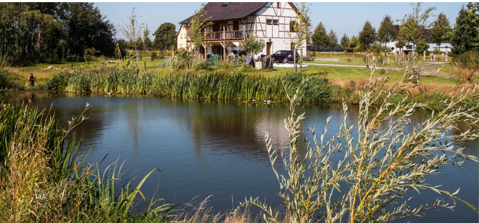
Der 2014 neu angelegte, naturnahe Feuerlöschteich in Nebelschütz
