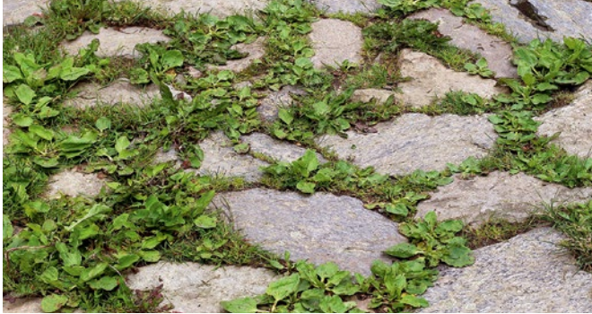
Unversiegelte Fugen werden durch Pflanzen besiedelt, mindern dadurch die Erhitzung und bilden Lebensräume für Insekten.
