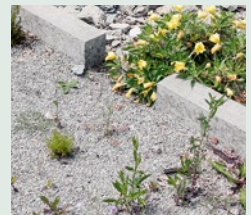
wassergebundene Decke, Parkplatz
