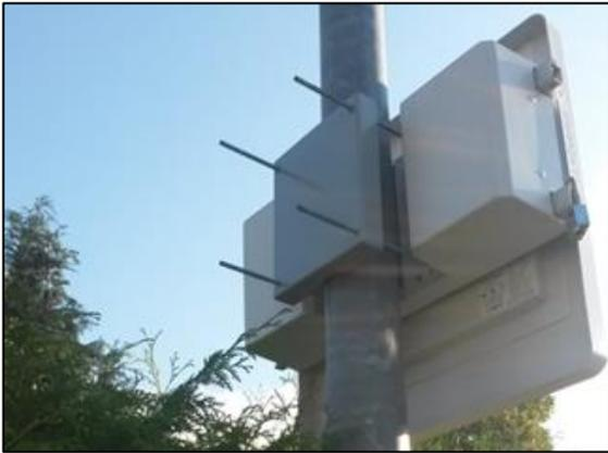
**Abbildung 3: Befestigung Geschwindigkeitsanzeigetafel**
