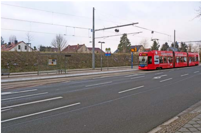
Abbildungen 23/24: Lärmschutzwälle an Georg-Schumann-Straße und Karl-Jungbluth-Straße in Leipzig
