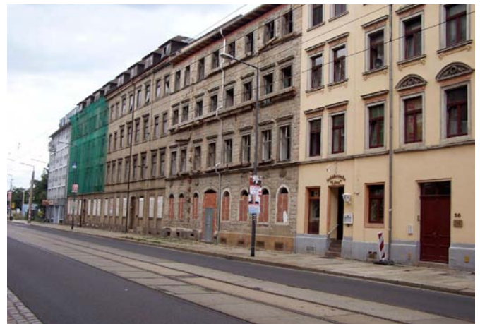
Abbildungen 27 / 28: Gebäudesicherung in Dresden / Abruch in Chemnitz (2010)
