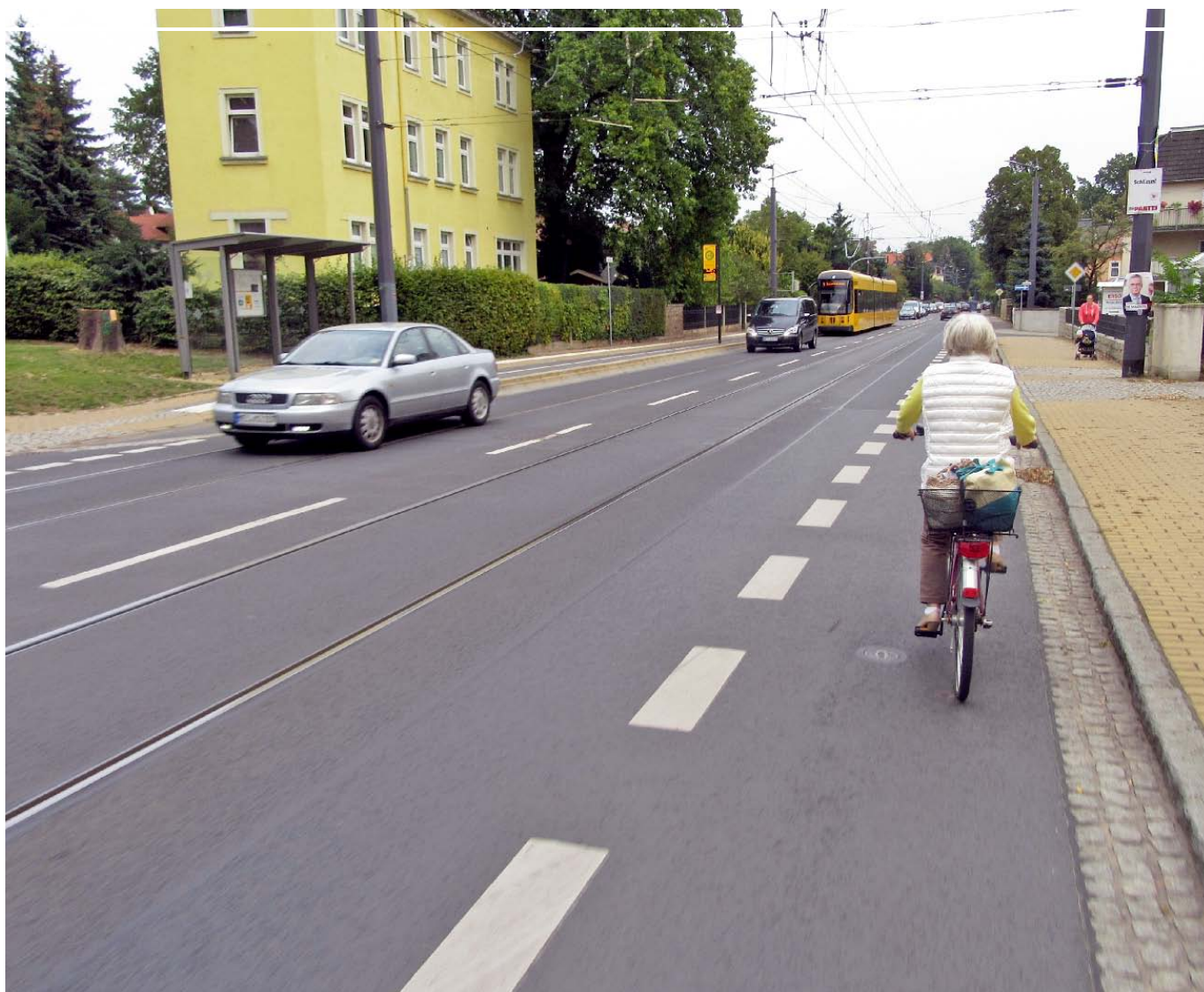
Abbildung 21: erneuerter Abschnitt mit Schutzstreifen für den Radverkehr auf der Meißner Straße in Radebeul
