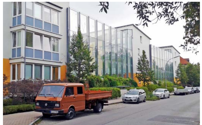
Abbildungen 25/26: Beispiele für Lärmschutzwände in Dresden und Freising
