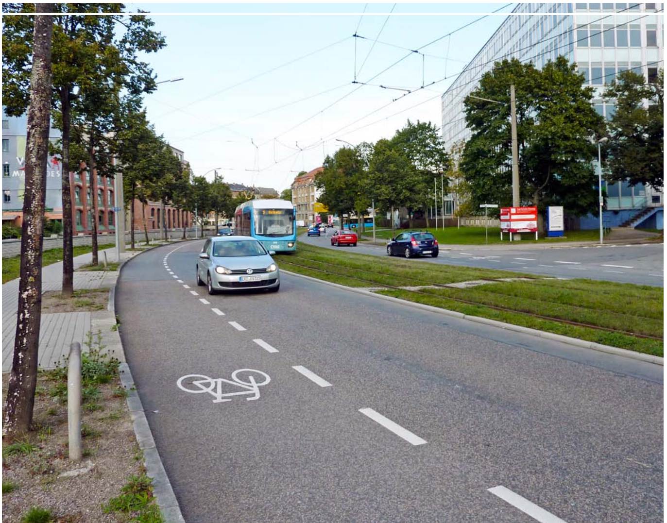
↓ Abbildung 8: Beispiel Chemnitz Annaberger Straße: neu angelegtes Rasengleis und Markierung Radschutzstreifen auf ehemals vierspuriger Fahrbahn
