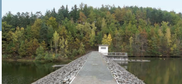
Staudamm der Vorsperre Bobenneukirchen
