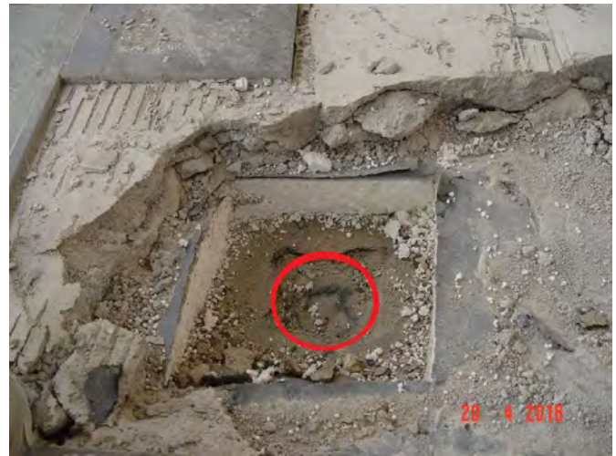
Abbildung 3: Sanierung eines in der Tiefe mit Teer abgedichteten Fußbodens (Quelle: Ingenieurbüro Schubach, Großpösna)
