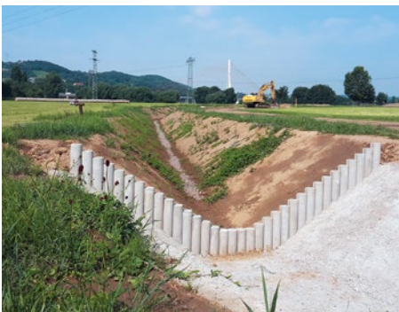
Betonierte Teilfläche eines Habitats des Dunklen Wiesenknopf-Ameisenbläulings
