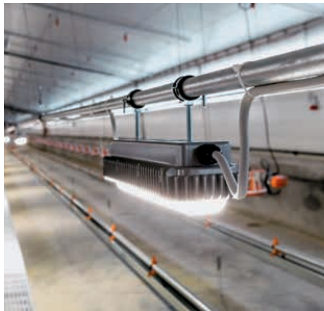
Abbildung 25: LED-Leuchte im Geflügelstall
