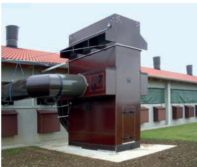
Abbildung 23: Nachgerüsteter Abluft-Wärmetauscher an einem Hühnermaststall
