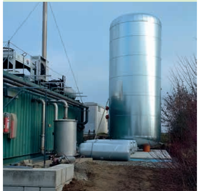
Abbildung 26: »Repowering« einer Biogasanlage zur Flexibilisierung der Stromproduktion durch Vergrößerung des Gasspeichervolumens, Zubau eines hocheffizienten BHKW und Nachrüstung eines Wärmepufferspeichers
