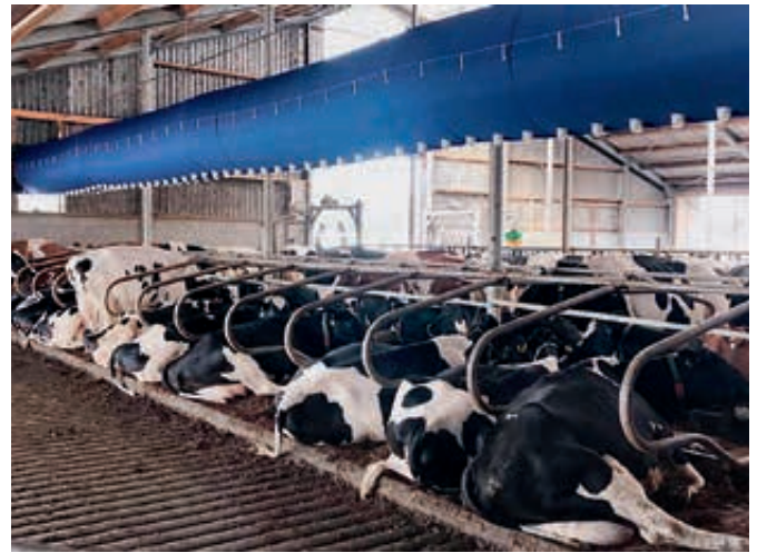
Abbildung 16: Schlauchbelüftungssystem zur Vermeidung von Hitzestress im Milchviehstall
