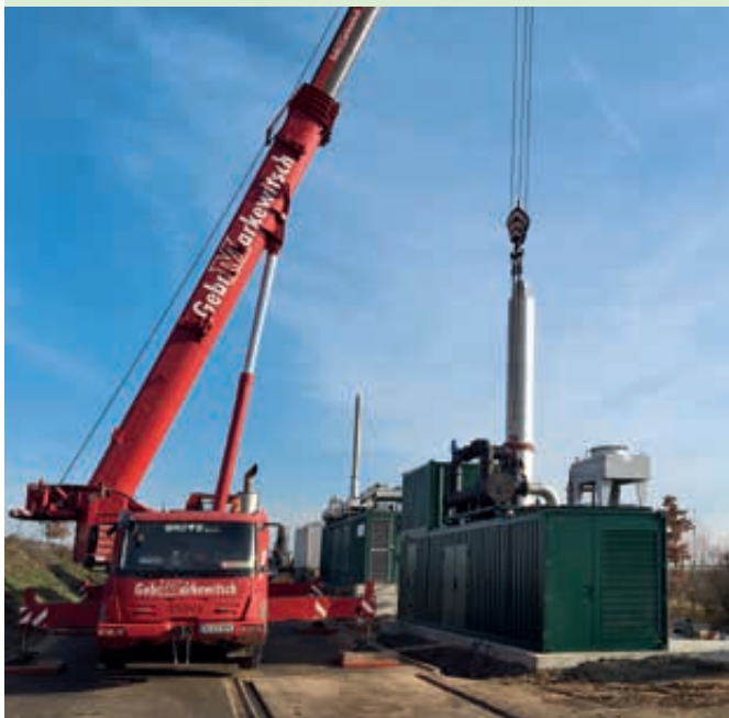
Abbildung 26: »Repowering« einer Biogasanlage zur Flexibilisierung der Stromproduktion durch Vergrößerung des Gasspeichervolumens, Zubau eines hocheffizienten BHKW und Nachrüstung eines Wärmepufferspeichers
