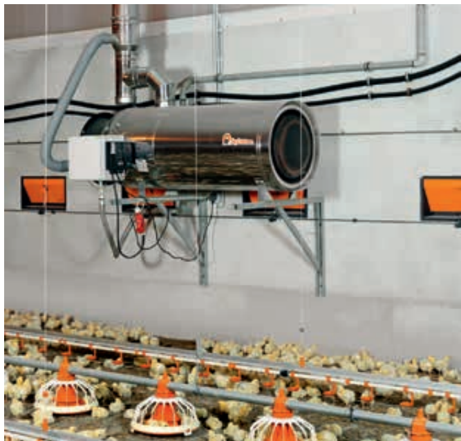
Abbildung 24: Raumluftunabhängiges Gasheizgerät mit Rauchgasabfuhr im Geflügelmaststall
