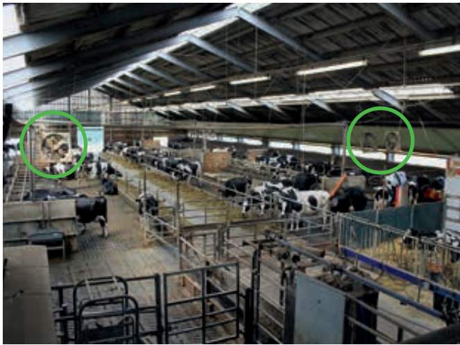
Abbildung 15: Axialventilatoren zur Hitzestressvermeidung in einem Kuhstall
