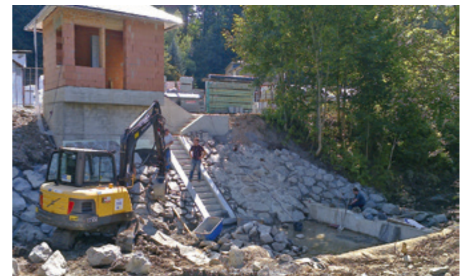
Abb. 10: Böschungsbau am Pegel Bienenmühle
