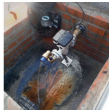
Abb. 16: Hugo-Ament-Quelle in Oberpfannenstiel mit Wasserzähler und DFÜ
