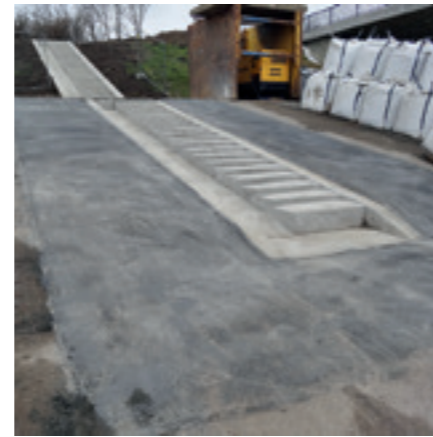
Abb. 13: Wiederherstellung der Dichtung am Pegel Zitzschen
