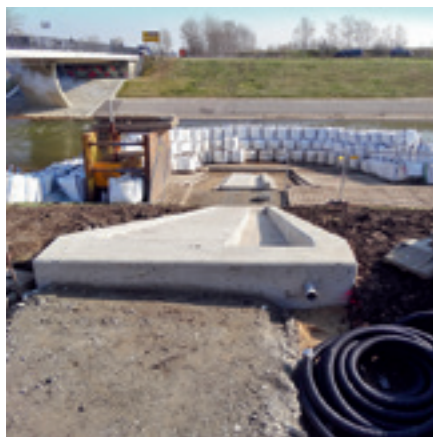
Abb. 14: Bau der Pegeltreppe am Pegel Zitzschen
