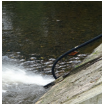
Abb. 12: Spülung des Zulaufrohres am Pegel Adorf 1
