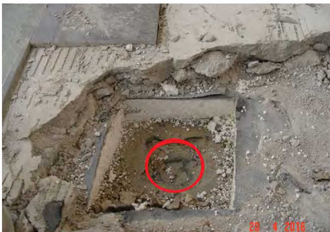
Abbildung 13: Sanierung eines in der Tiefe mit Teer abgedichteten Fußbodens (Quelle: Ingenieurbüro Schubach, Großpösna)
