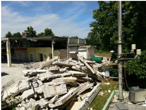
Abbildung 29: Abrissarbeiten in unmittelbarer Umgebung des Messcontainers Zittau-Ost, Foto: BfUL
