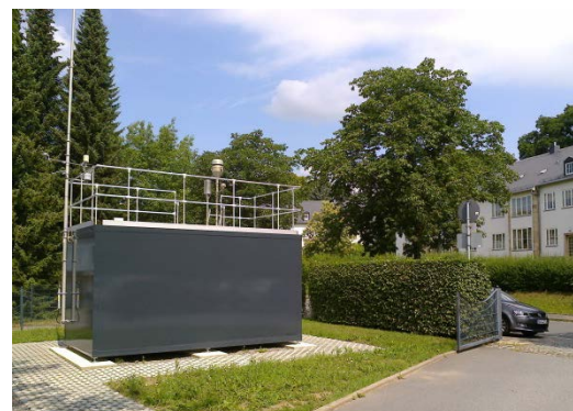
Abb. 6: neue Messstation in der Hans-Link-Straße in Chemnitz
