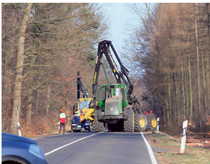
Vollsperrung der B 176 zwischen Ballendorf und Colditz – mittels Großtechnik werden mehrere Tage Gefahrenbäume gefällt und zerteilt; Foto: Susann Richter
