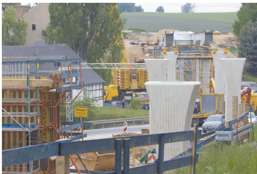
Bild 15 Brückenbau Ottendorf (© LISt)
