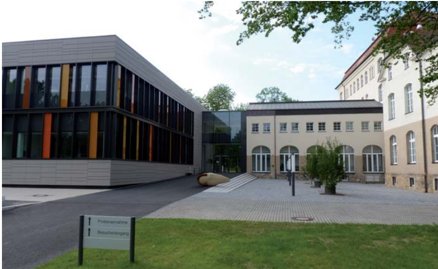
Abb. 1: Labor- und Bürogebäudeneubau - Haupteingangsbereich, Anschluss zum Altbau
