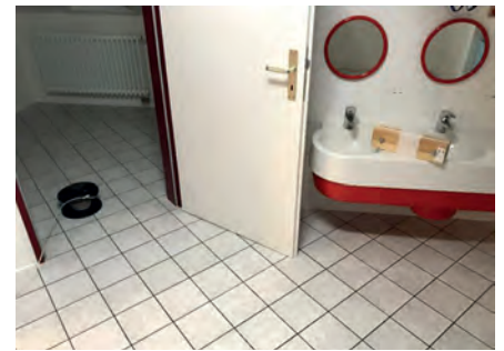
Messstelle und Prüfkörper im Bad
