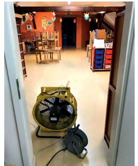
„Eingasse“ im Gruppenraum des Dachgeschosses
