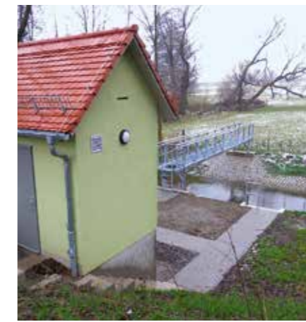
Abb. 6: Neuer Jeschke-Pegel Kleinwolmsdorf mit Messsteg
