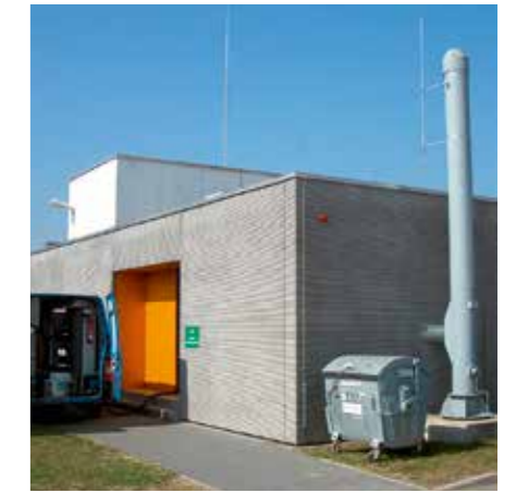
Abb. 12: Hackschnitzelheizung am Lehr- und Versuchsgut Köllitsch
