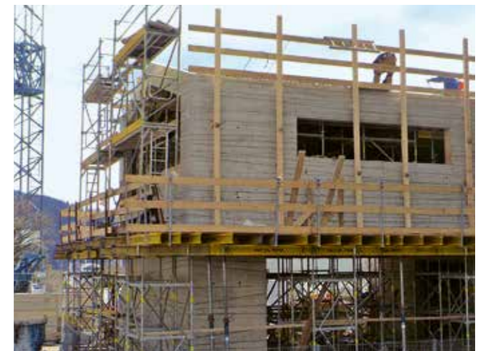
Abb. 6: Rohbau Gewässergütemessstation Schmilka
