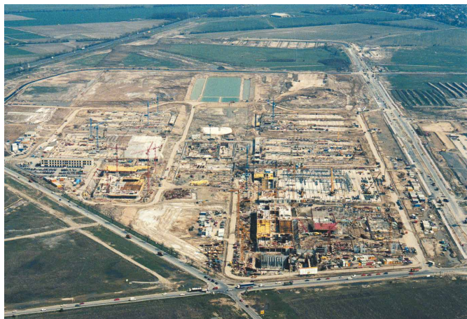
Heinz Morgenstern: Baustand Neue Messe, 20.04.1994, Kleinbildnegativ (StadtAL, Samml. Morgenstern Nr. 1786)
