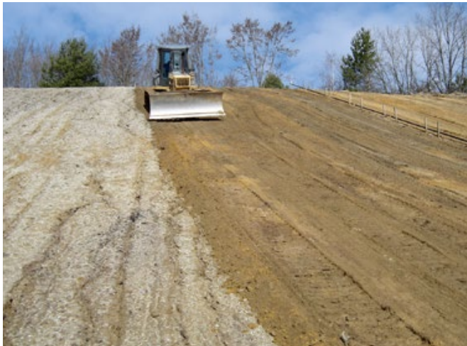
Abschließende Profilierung einer Tagebauböschung für die anschließende Aufforstung mit gebietsheimischen Baumarten
