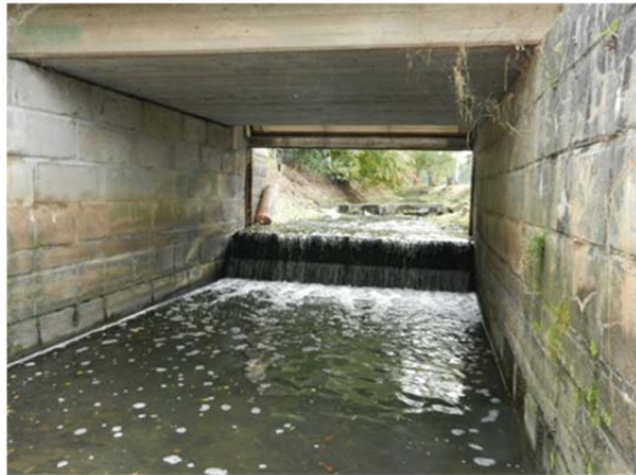
Abbildung 9: Wehr Keula mit Pegel und zusätzlich hilfweisem Brett-Aufstau
