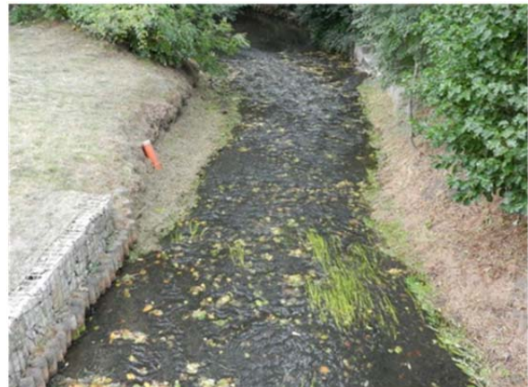
Abbildung 8: Lange Gleite mit starkem Rückstau (links) und viel Gefällevernichtung (rechts) im Bereich der Straßenkreuzung S 95.
