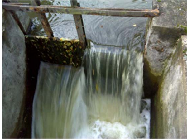
Abbildung 4: Wehr Wasserkraftwerk Kobermühle im geschlossenen Zustand (links) und einseitig leicht geöffnet zum Durchlass von Falllaub (rechts)
