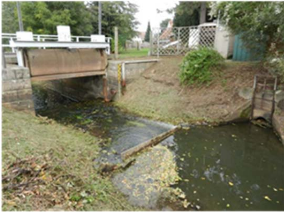
Abbildung 9: Wehr Keula mit Pegel und zusätzlich hilfweisem Brett-Aufstau
