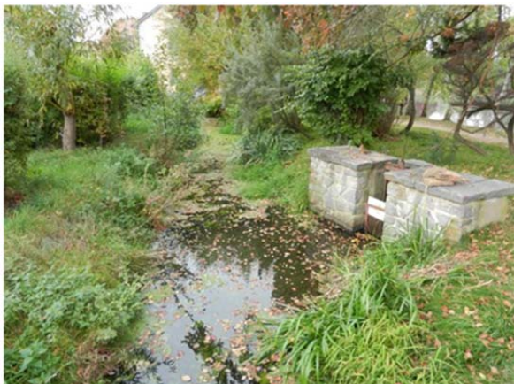
Abbildung 5: Mühlgraben mit Einlaufbauwerk Stadtteich (links) sowie Schlammfang (rechts) kurz vor der Mündung in die Schwarze Elster
