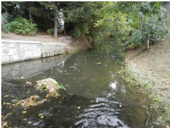
Abbildung 8: Lange Gleite mit starkem Rückstau (links) und viel Gefällevernichtung (rechts) im Bereich der Straßenkreuzung S 95.
