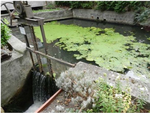
Abbildung 4: Wehr Wasserkraftwerk Kobermühle im geschlossenen Zustand (links) und einseitig leicht geöffnet zum Durchlass von Falllaub (rechts)
