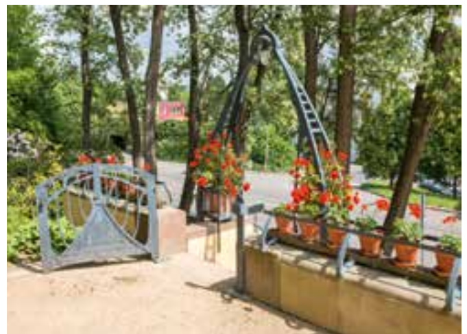
Rekonstruierte Terrassenmauer mit wieder aufgefundenem Torflügel
