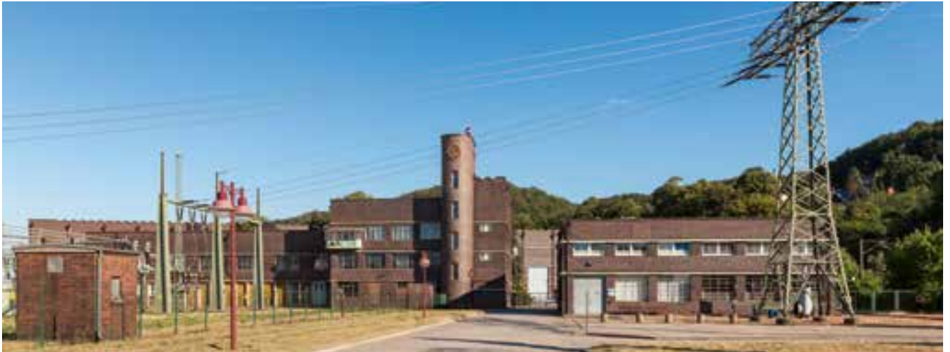
Verwaltungs- und Funktionsgebäude von Nordwesten
