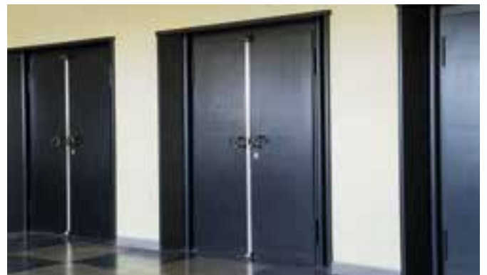
Aulatüren von außen
