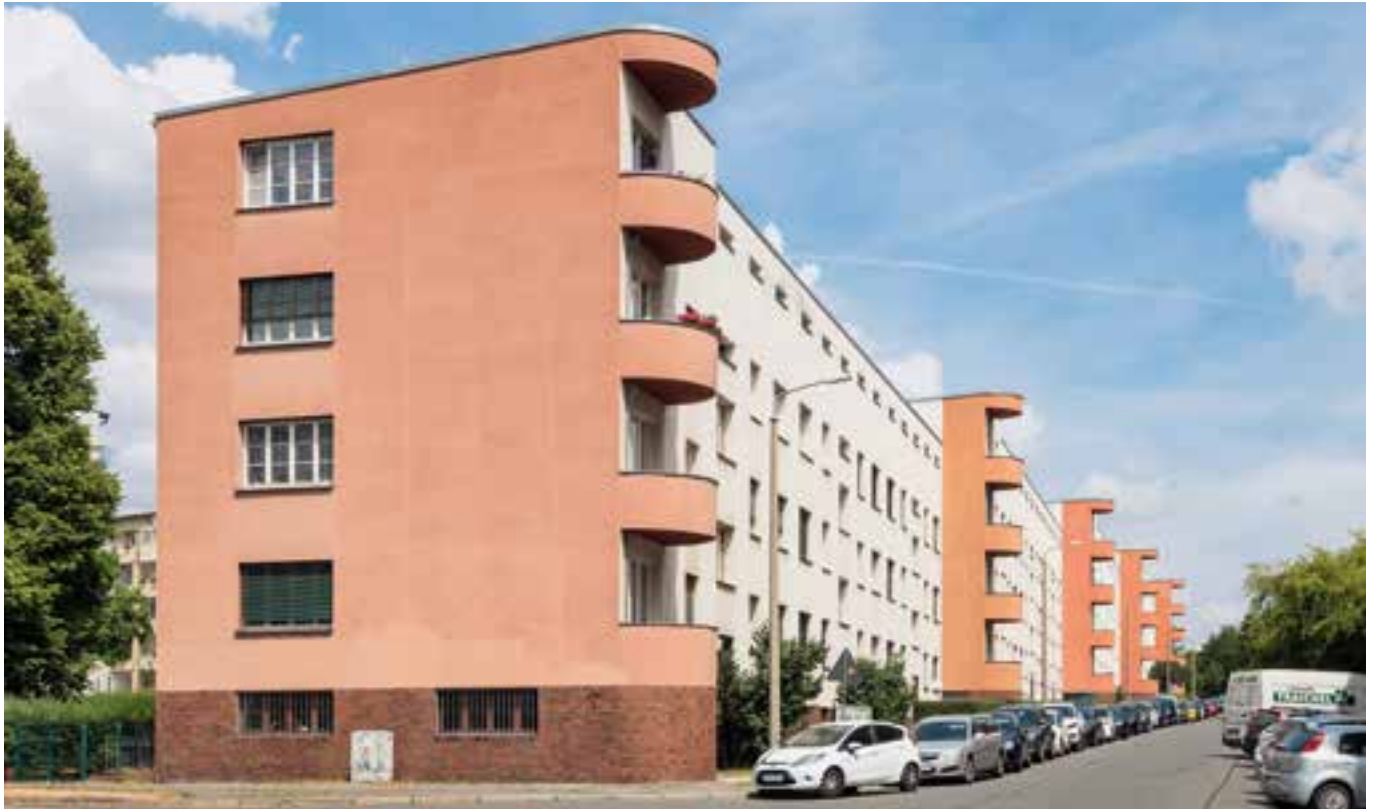
Blick in die Faradaystraße von Südosten
