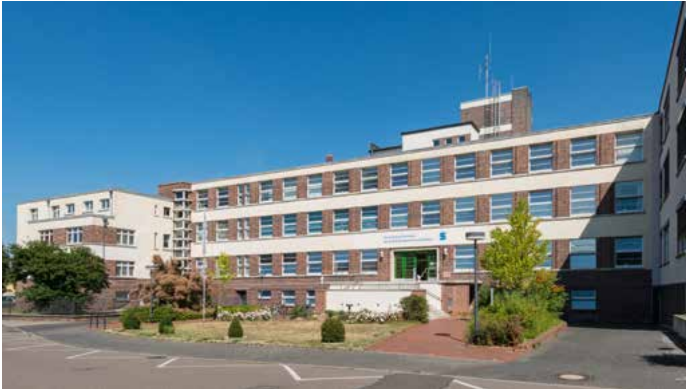
Ansicht des Hauptgebäudes von Südwesten
