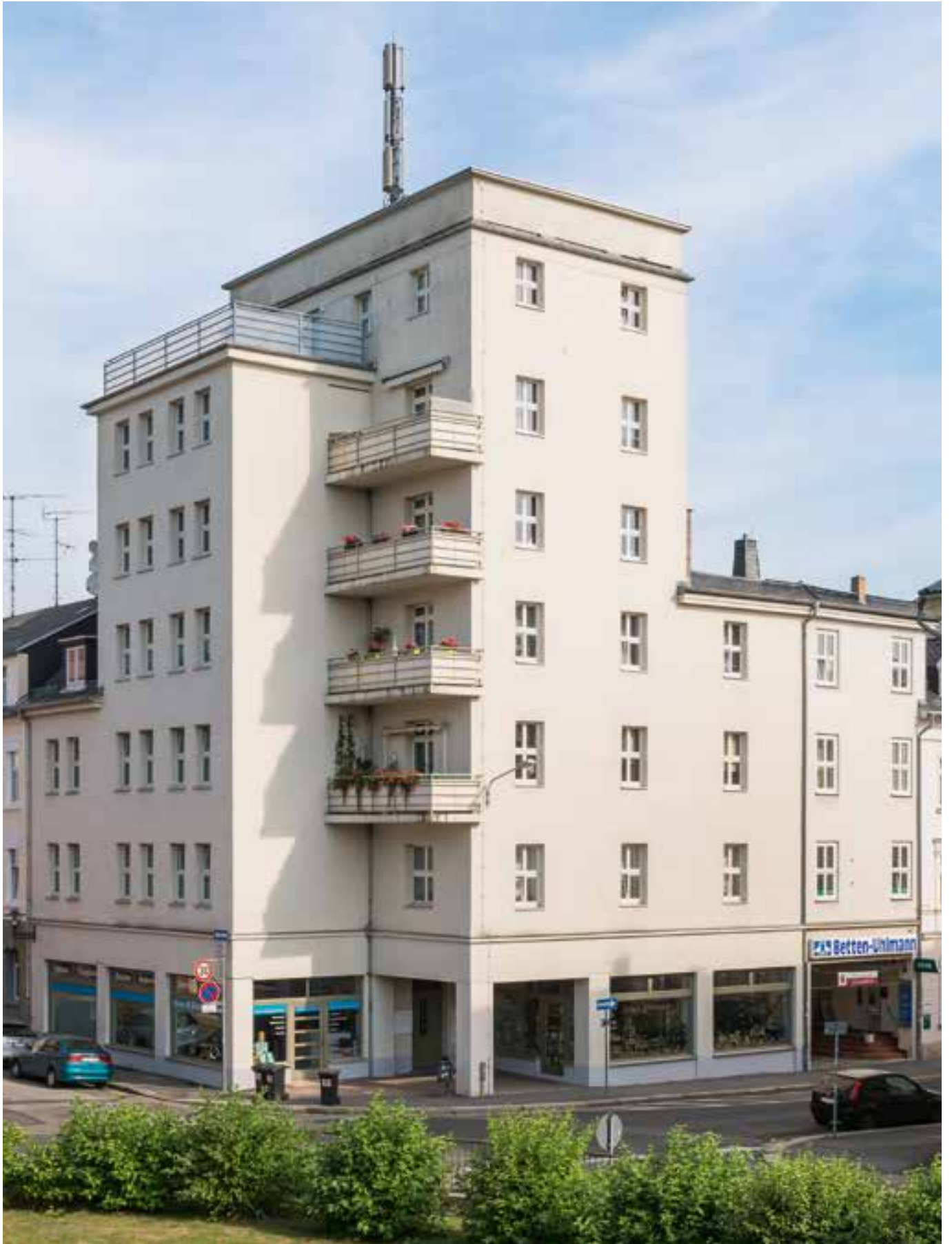
Gesamtansicht von Südosten
