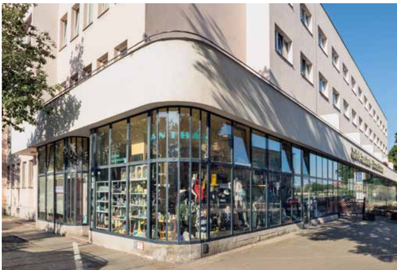
Eckgeschäft Rehefelder / Wurzener Straße von Nordosten
