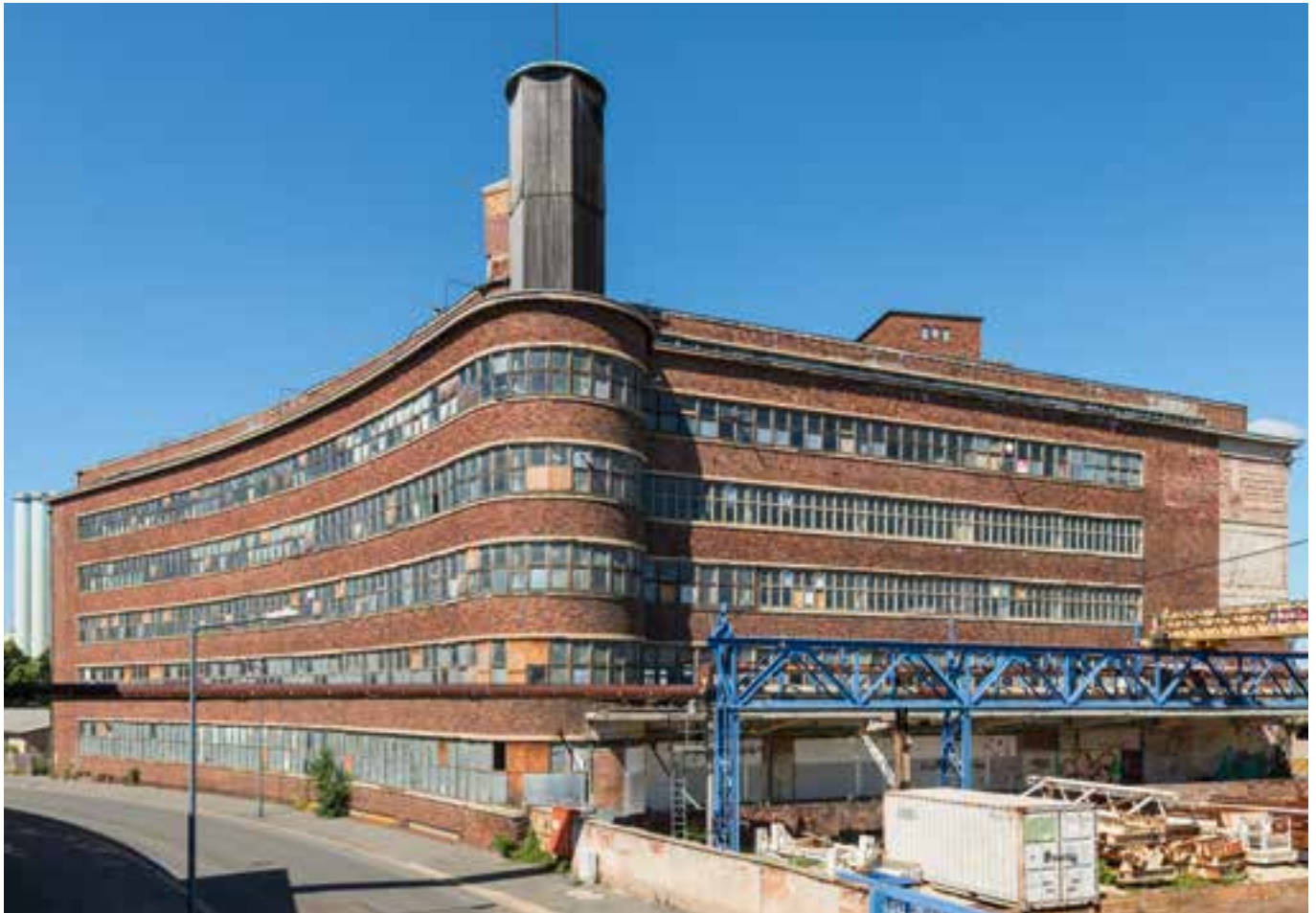
Fleischereigebäude von Südwesten
