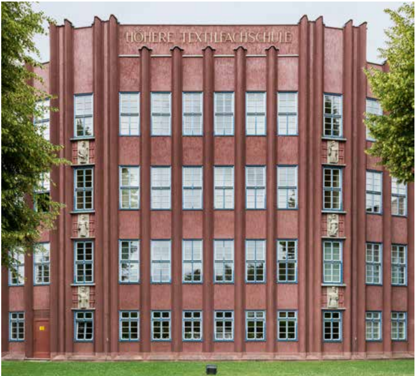
Hauptbau von Südosten
