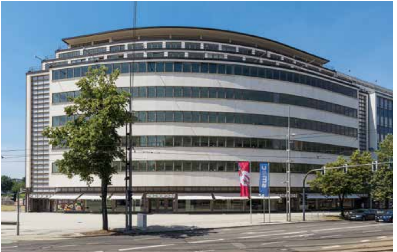
Hauptansicht von Osten
