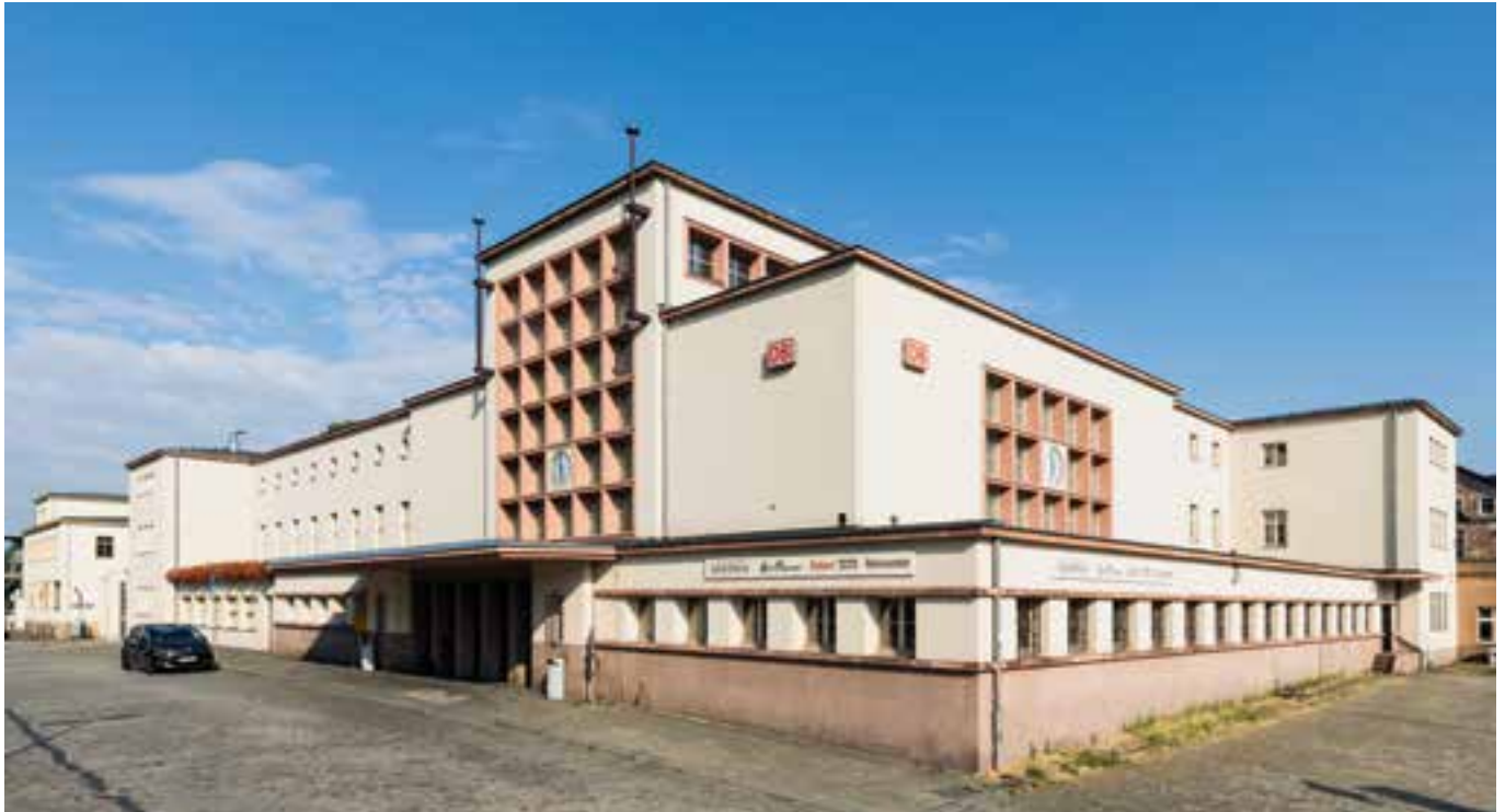
Gesamtansicht von Nordwesten
