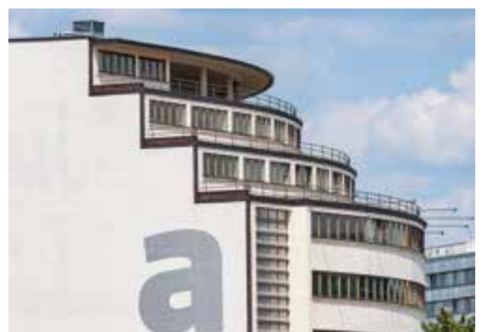
Überdachte Terrasse (oben) und gestaffelte Obergeschosse (unten)
