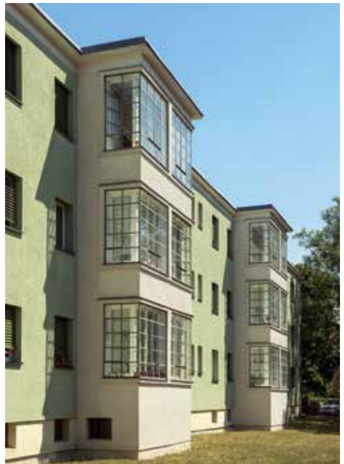
Rückseite am Norderneyer Weg von Nordwesten
