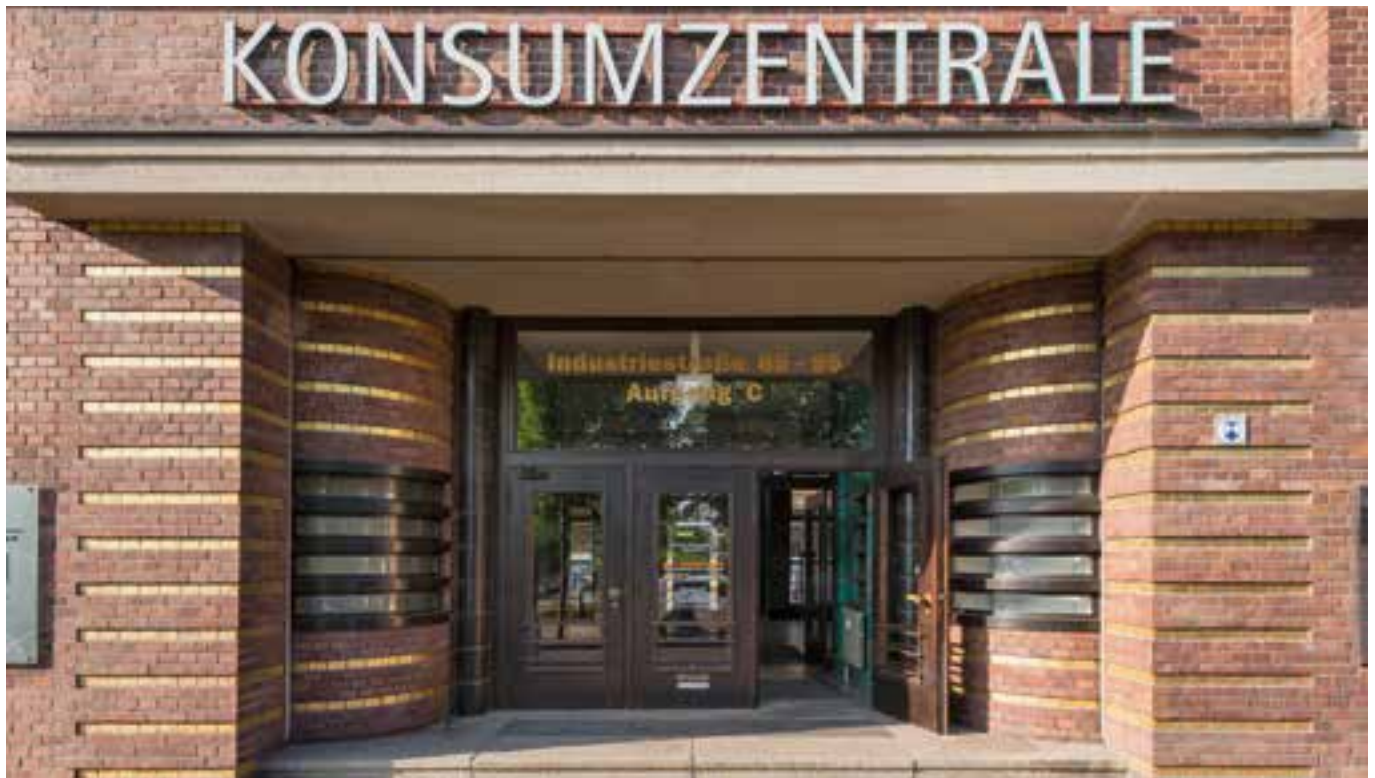
Eingang von Norden
