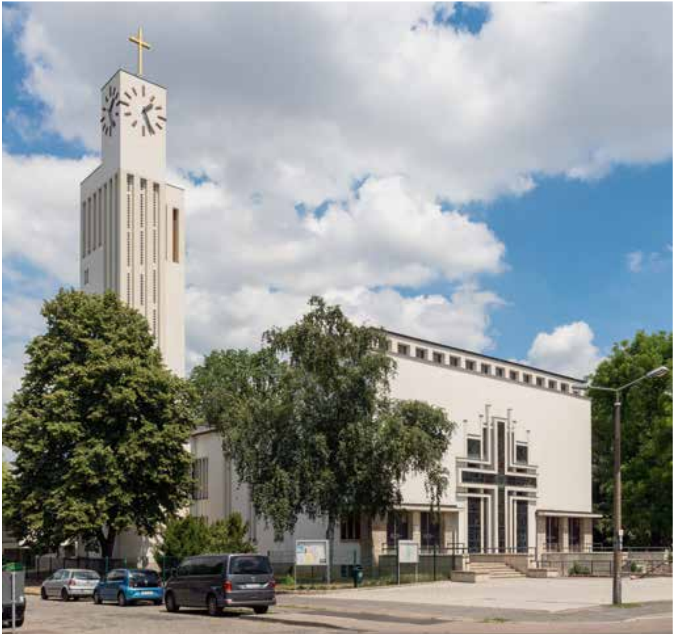
Gesamtansicht von Südwesten
