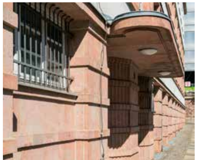
Fassadengestaltung am Haupteingang
