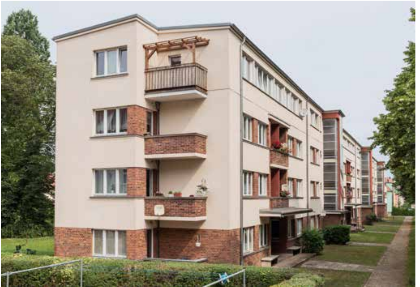
Gesamtansicht von Südosten
