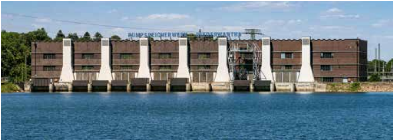
Maschinenhaus und unteres Speicherbecken von Südosten
