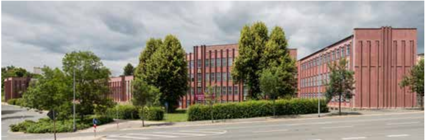
Gesamtansicht von Südosten
