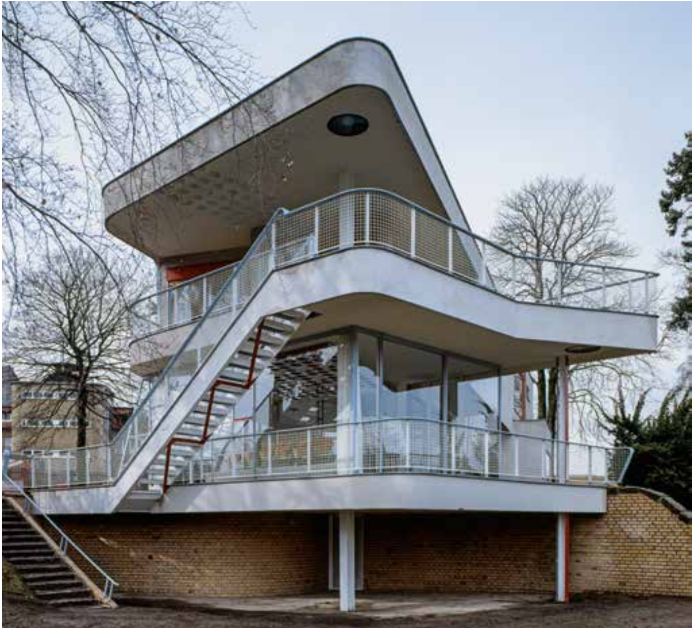
Gartenseite von Nordosten
