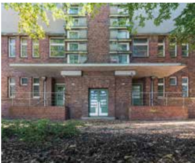
Ehemaliges Infektionshaus von Norden ...
