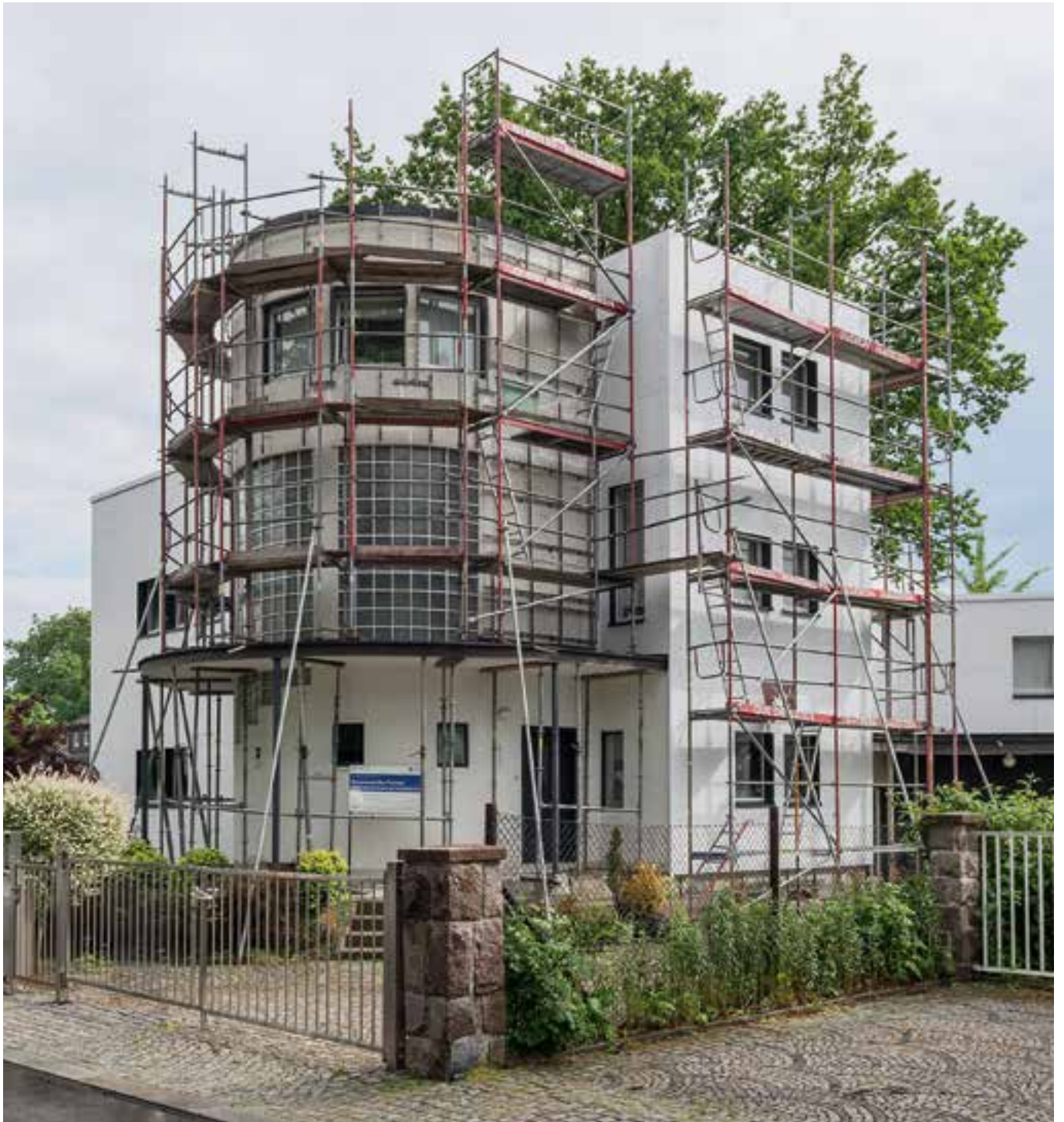
Chemnitz, Haus Feistel
