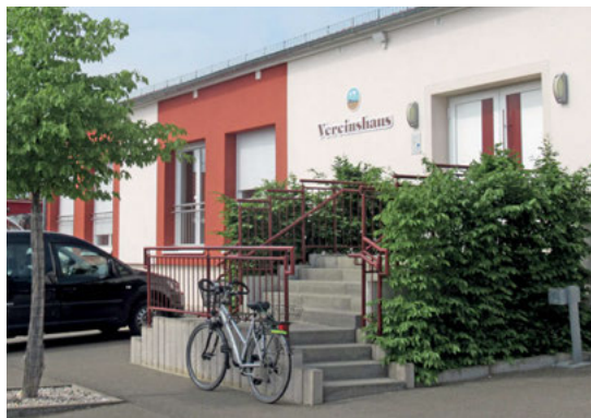
Das Vereinshaus in der früheren Kaufhalle
