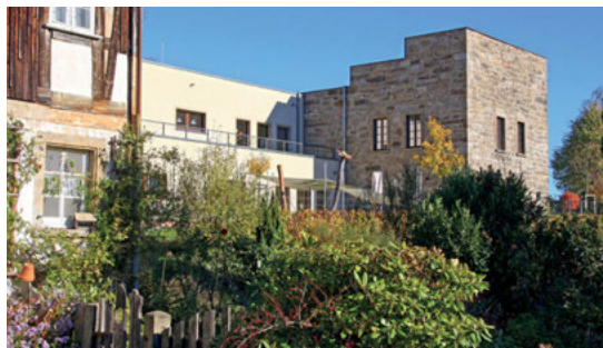
Blick zur neuen Kindertagesstätte im alten Trockenturm
