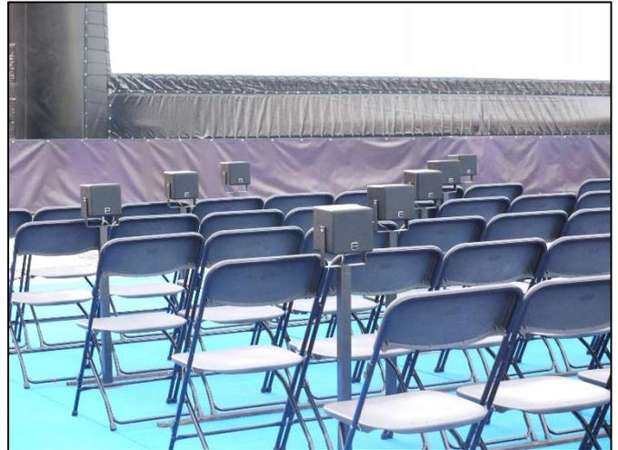
**Abbildung 26: Praktische Umsetzung des dezentralen Lautsprecherkonzeptes**
