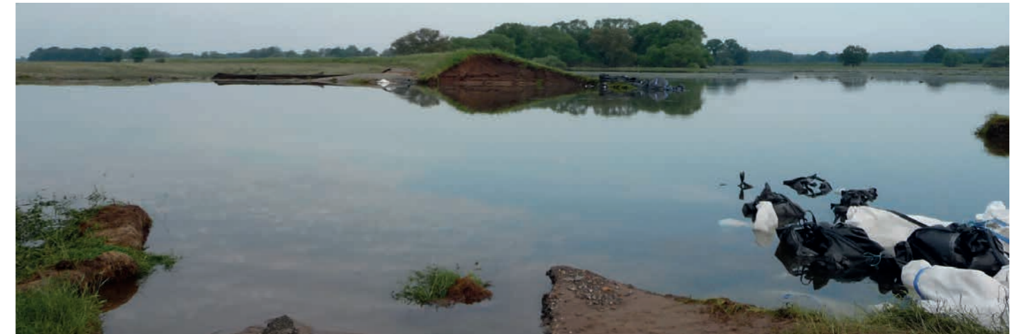
Deichbruch an der Vereinigten Mulde zwischen Bad Düben und Hohenprießnitz
