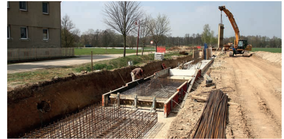
Gründung der Hochwasserschutzwand
