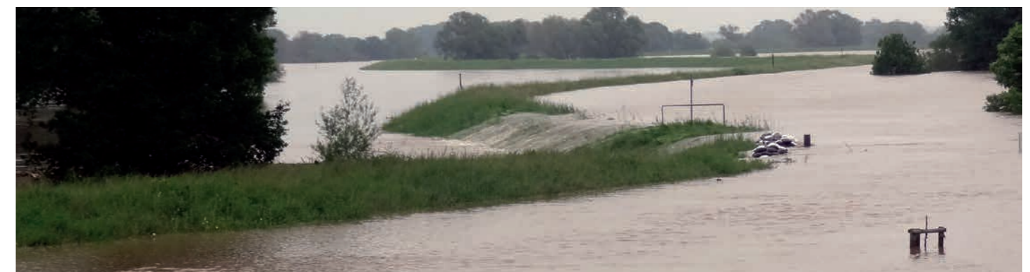
Deichbruch am Hochwasserschutzdeich Löbnitz - Bad Düben an der Landesgrenze zwischen Sachsen und Sachsen-Anhalt
