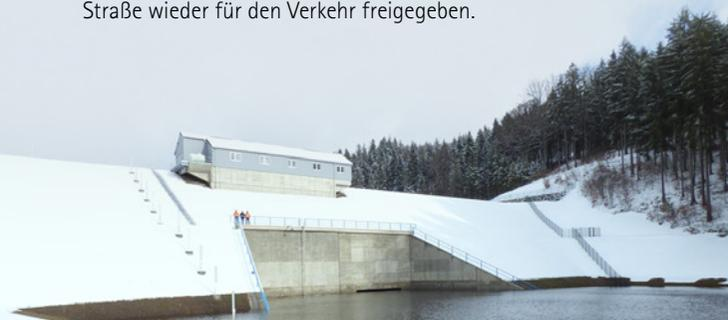
Das Hochwasserrückhaltebecken Niederpöbel im Nasstest
