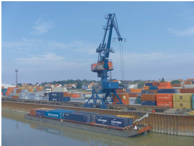
Bild 30 Containerterminal Hafen Riesa, Schiffsentladung (© Sächsische Binnenhäfen Oberelbe GmbH)
