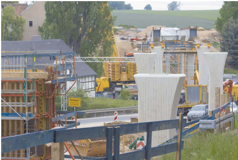
Bild 25 Brückenbau Ottendorf (© LISt)
