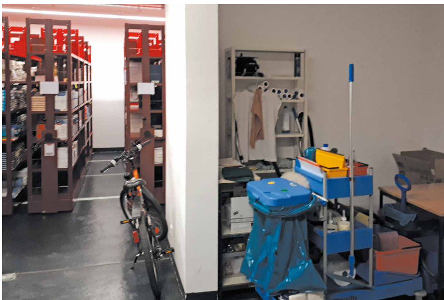
Vermeidbarer Feuchteintrag als Folge unsachgemäßen Nutzerverhaltens, Lagern und Trocknen von Reinigungsgeräten bzw. Lappen in einem Archiv (Quelle LUA Sachsen)
