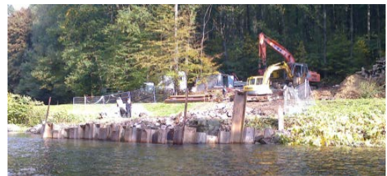
Abb. 6: Pegel Göritzshain im Bau.
