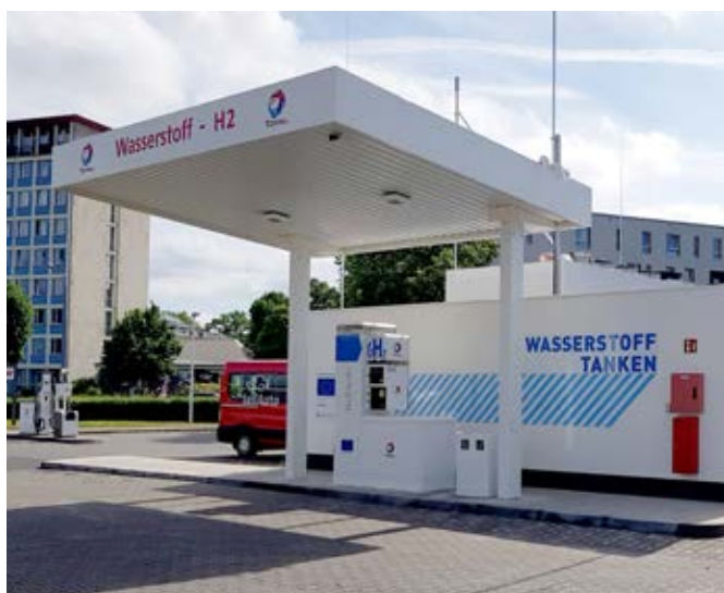
Abbildung 42: Wasserstofftankstelle in Dresden – Wiener Straße
