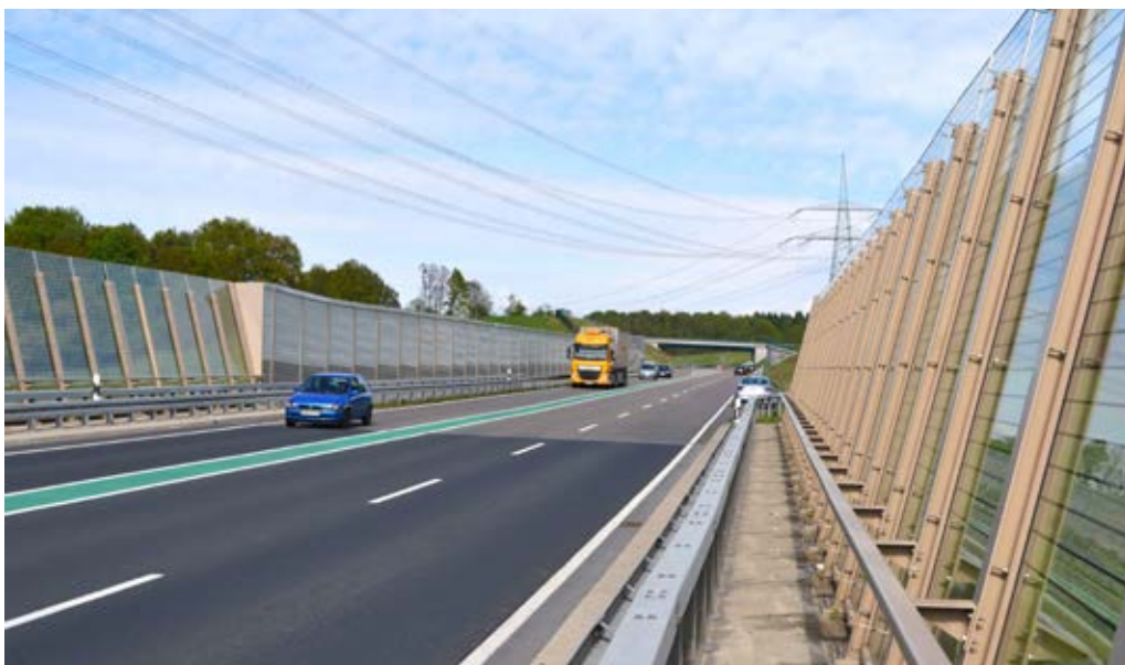
Abbildung 43: Staatsstraße S 177 südlich Pirna, Brückenbauwerk 10 über den Bonnewitzer Grund mit Lärmschutzeinrichtung
