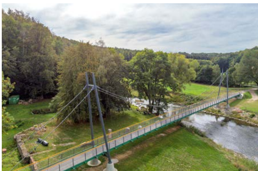
Abbildung 15: B 107 Chemnitztalradweg, Bauwerk 10
