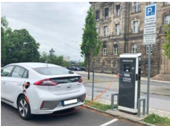
Abbildung 40: Ladesäule für Elektrofahrzeuge
