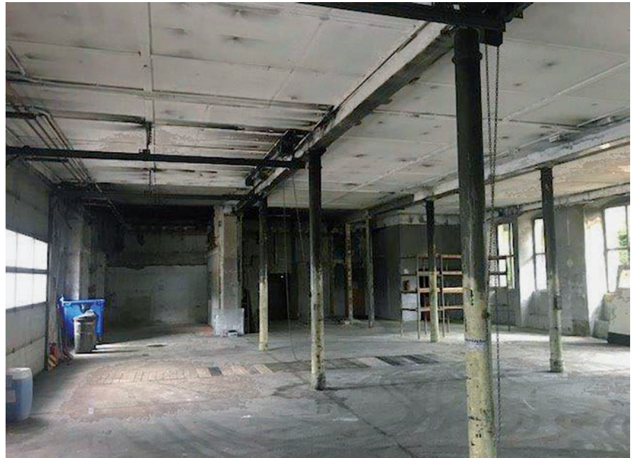
Lagerhalle vor Abbruch der asbesthaltigen Zwischendecke
