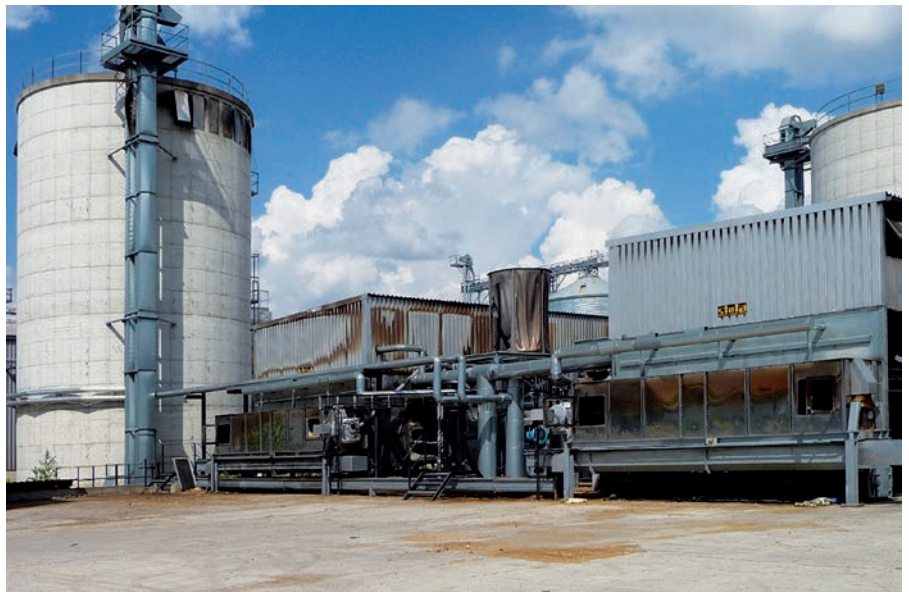
Aufgerissener Elevator und offene Explosionsdruckentlastung (oben links), ausgebrannte Bandtrockneranlagen (Bildmitte)
