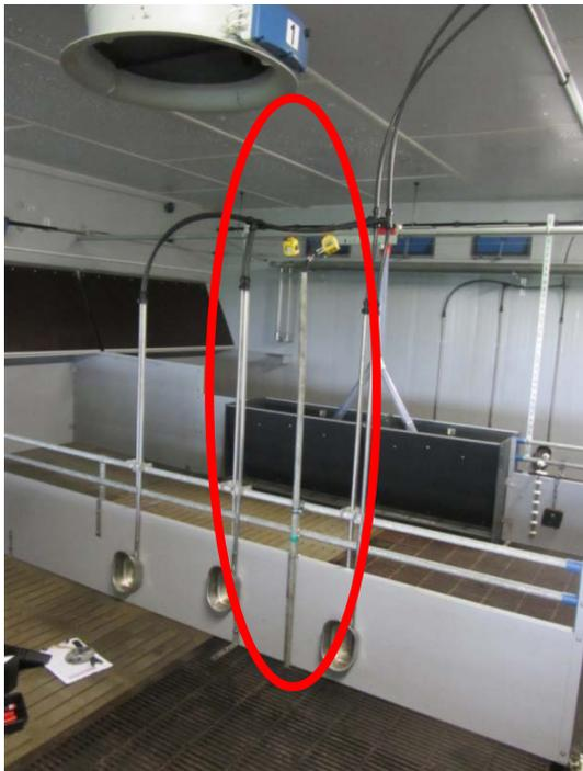
**Abbildung 5: Der Metallstab wurde durch ein Rohr geschützt und mit Schellen an der Buchtentrennwand arretiert.**
