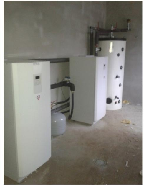
**Abbildung 2: Die beiden Wärmetauscher vor Inbetriebnahme der Anlage. Der Boiler im Hintergrund ist der Wärmespeicher für die Heizung.**
