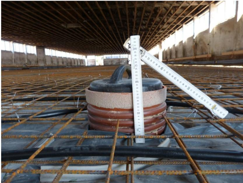
**Abbildung 1: Güllekühlleitung, Nahaufnahme während der Verlegung**
