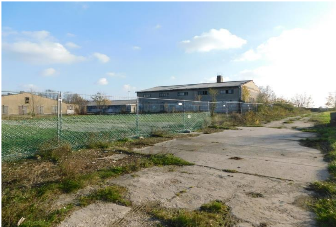
Abbildung 13: Ansicht von Hof und Gebäude der Brachfläche Göbelschwitz (Foto: StadtLand GmbH 2017)
