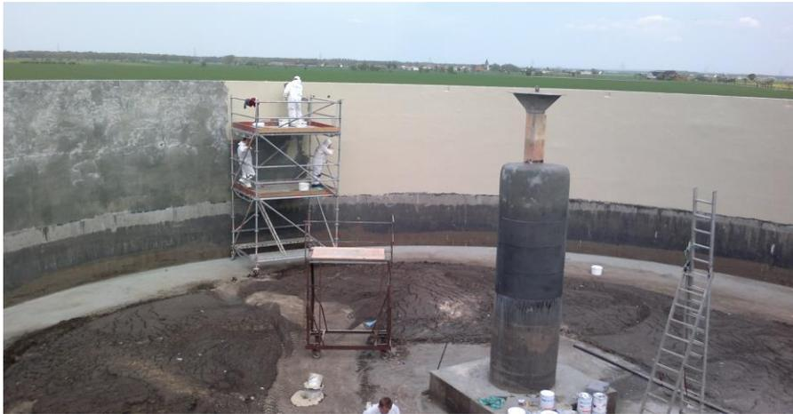
**Abbildung 27: Beschichtungsarbeiten während Reparatur eines Betonbehälters; ID01-06**
