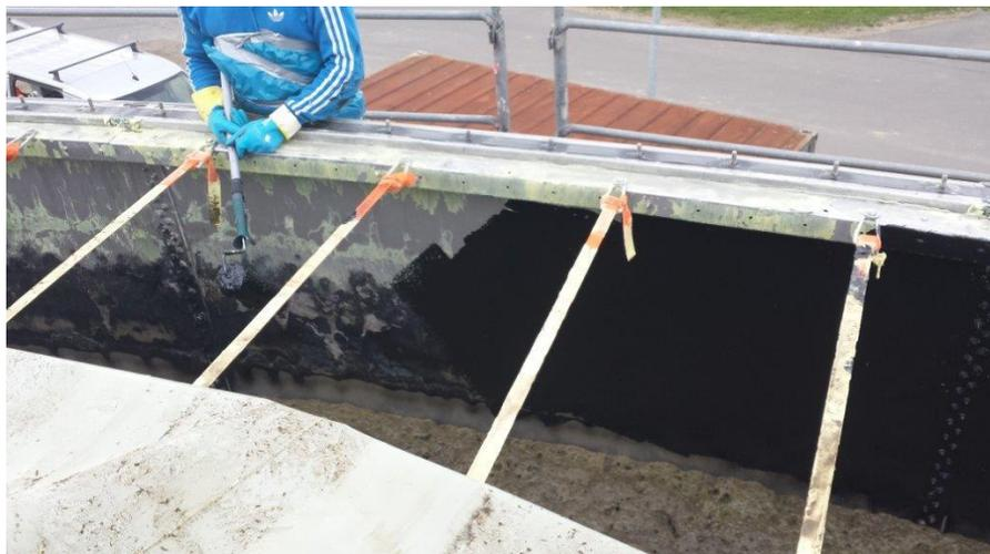
**Abbildung 26: Beschichtungsarbeiten während Reparatur eines Edelstahlbehälters; ID03-01**
